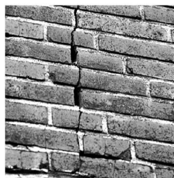
Ремонт и реставрация кирпичной кладки.
